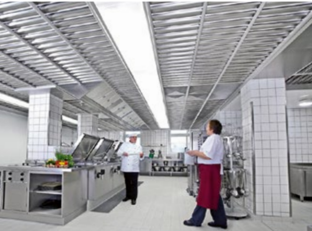
Kolping- haus, Estugarda
