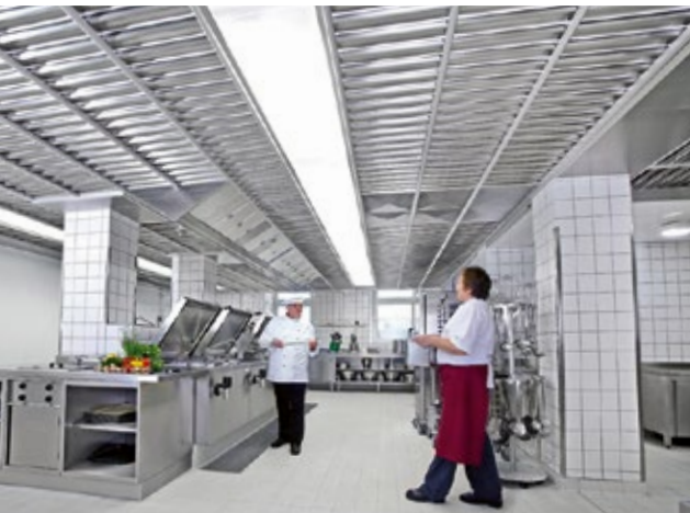
Kolping- haus Stuttgart
